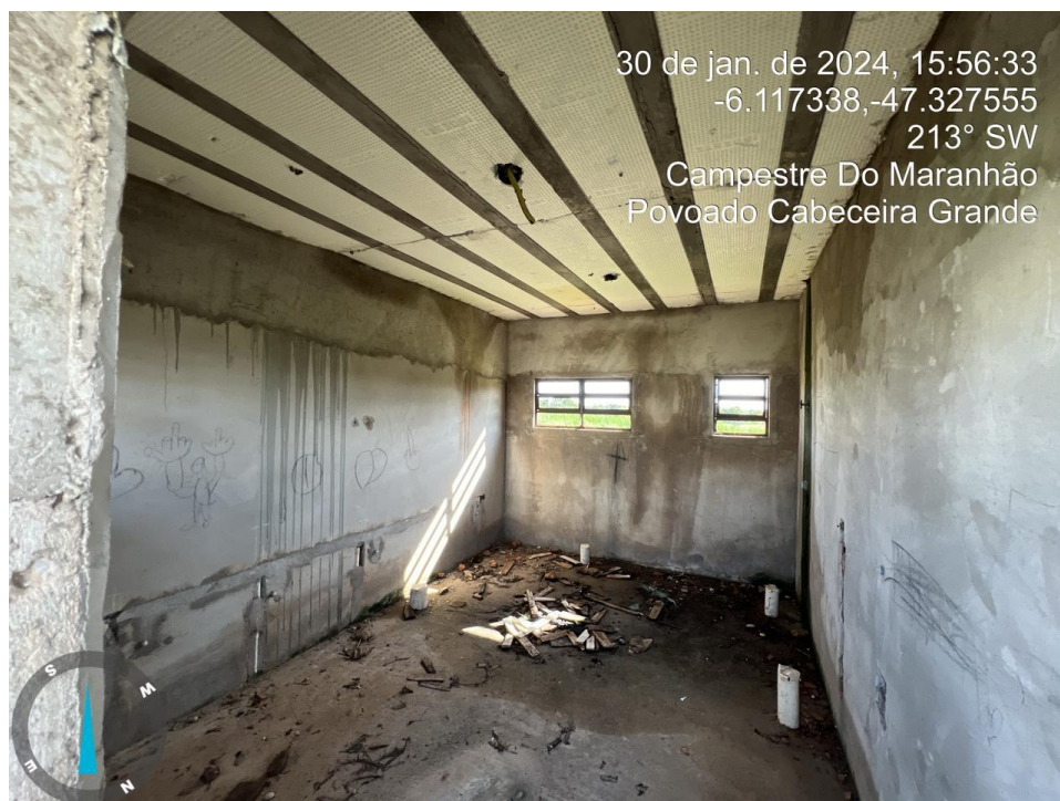
Figura 25 –Banheiro bloco de serviço. Fonte: elaboração própria.
