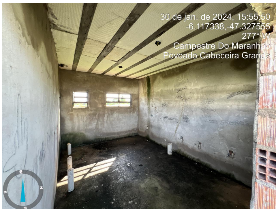
Figura 26 –Banheiro bloco de serviço. Fonte: elaboração própria.
