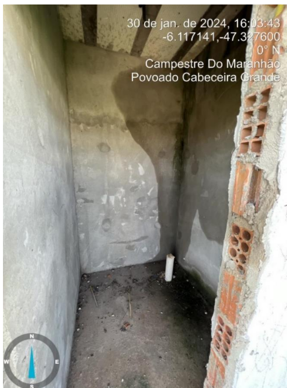
Figura 11 – Banheiro Masculino bloco administrativo. Fonte: elaboração própria.
