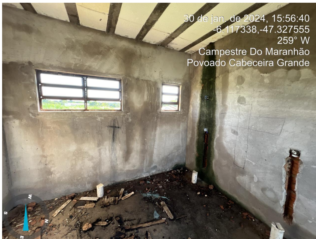
Figura 24 –Banheiro bloco de serviço. Fonte: elaboração própria.
